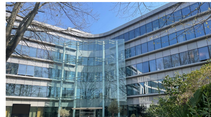
8-10 RUE VICTOR NOIR - NEUILLY (92) Vente de 3 500 m 2 de bureaux de UNOFI à un UTILISATEUR Sale of 3,500 sqm of offices from UNOFI to an END-USER
