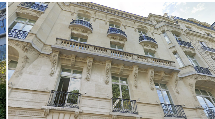
23 RUE DE L'AMIRAL D'ESTAING - PARIS 16 Vente de 4 000 m 2 de bureaux de CARMF à COVEA Sale of 4,000 sqm of offices from CARMF to COVEA
