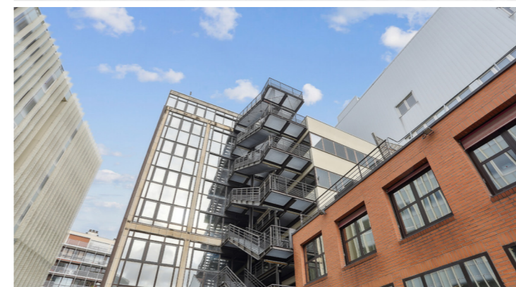
66 RUE JEAN BLEUZEN - VANVES (92) Vente de 3 700 m 2 de bureaux de CBRE AM à BOUYGUES / MIRABAUD Sale of 3,700 sqm of offices from CBRE AM to BOUYGUES / MIRABAUD
