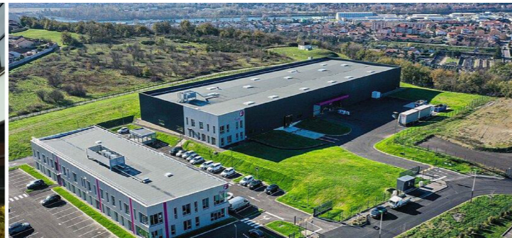
646 CHEMIN DE LA JACONNE - CHASSE-SUR-RHÔNE (38) Vente de 6 213 m 2 de logistique de PURPLE DEVELOPPEMENT à PAREF Sale of 6,213 sqm of logistics from PURPLE DEVELOPPEMENT to PAREF
