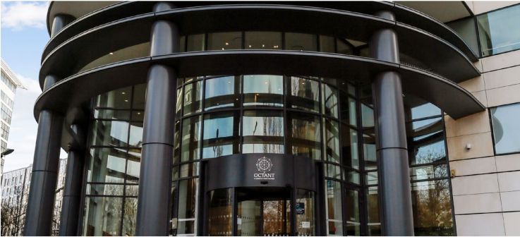
OCTANT - LEVALLOIS-PERRET 400 m 2 de bureaux loués à MANE 400 sqm of offices leased to MANE BAILLEUR / LESSOR : GECINA
