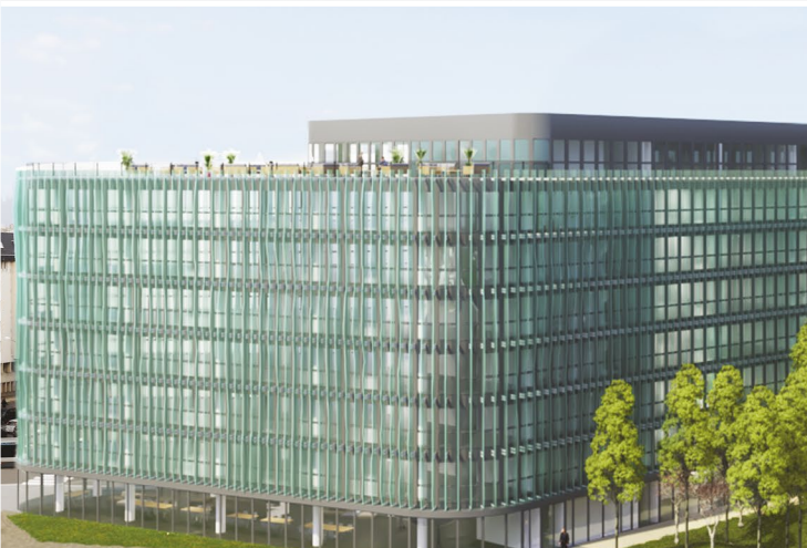
KANAL - PANTIN (93) Mandat de commercialisation de 20 500 m² à louer (Juillet 2021) Rental mandate of 20,500 sqm (July 2021) BAILLEUR / LESSOR: JC DECAUX HOLDING / PRD OFFICE
