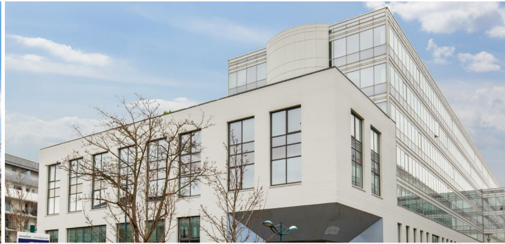
CLEVER 2 - GENNEVILLIERS (92) 1 770 m 2 de bureaux loués à EUGENE PERMA 1,770 sqm of offices leased to EUGENE PERMA BAILLEUR / LESSOR : BLACKROCK
