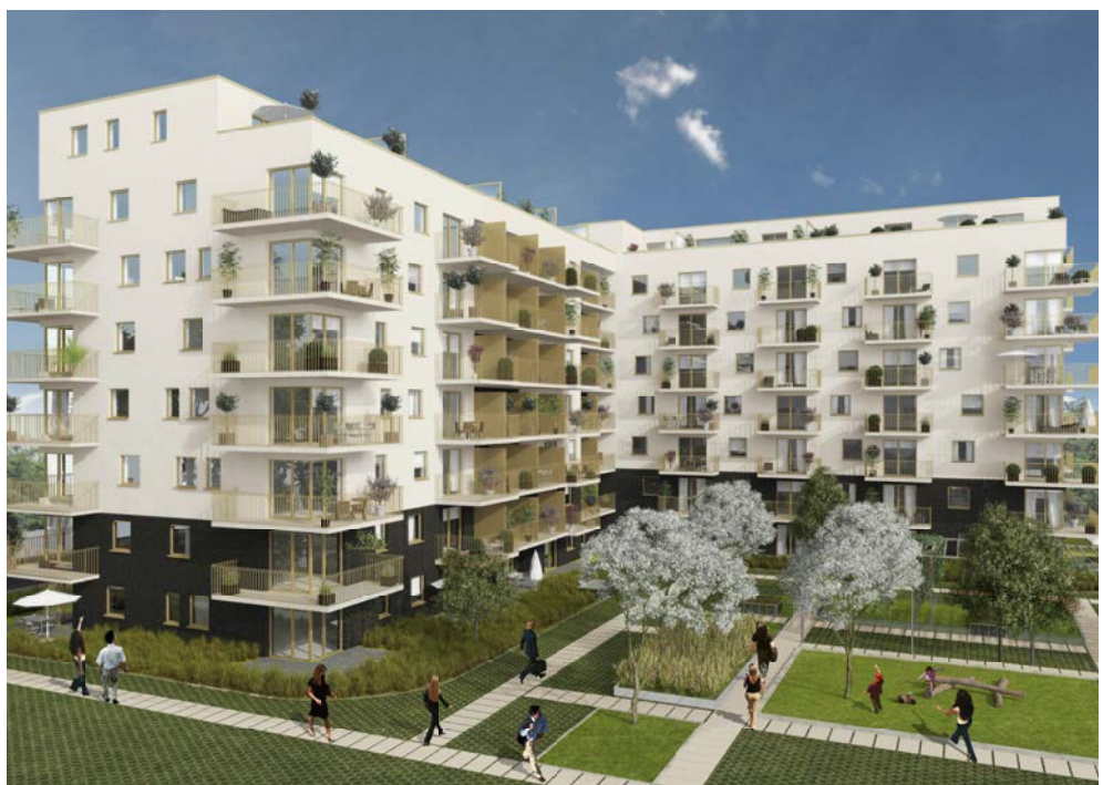
Innenansicht des Living Lyon
