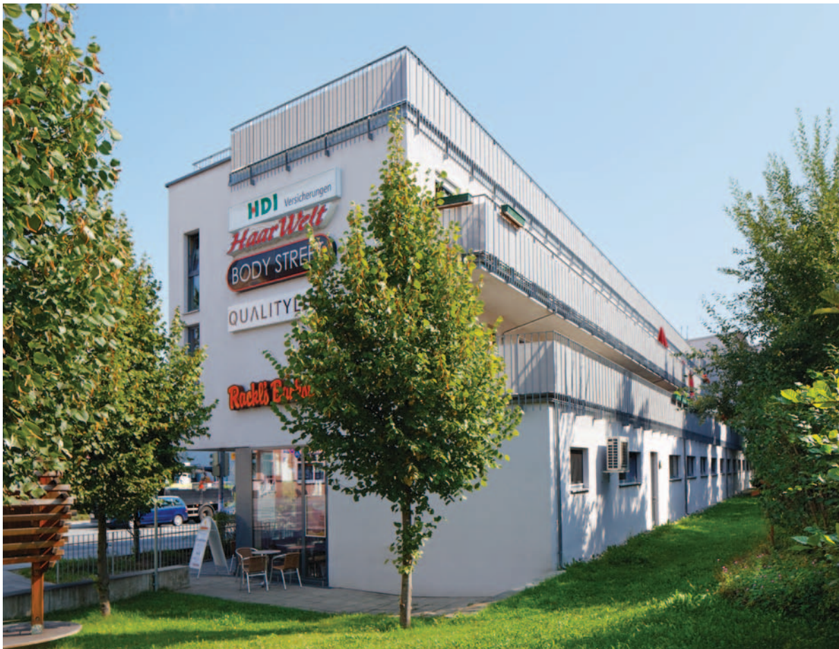
Verdistrasse, Obermenzing, Foto: Bernd Perlbach
