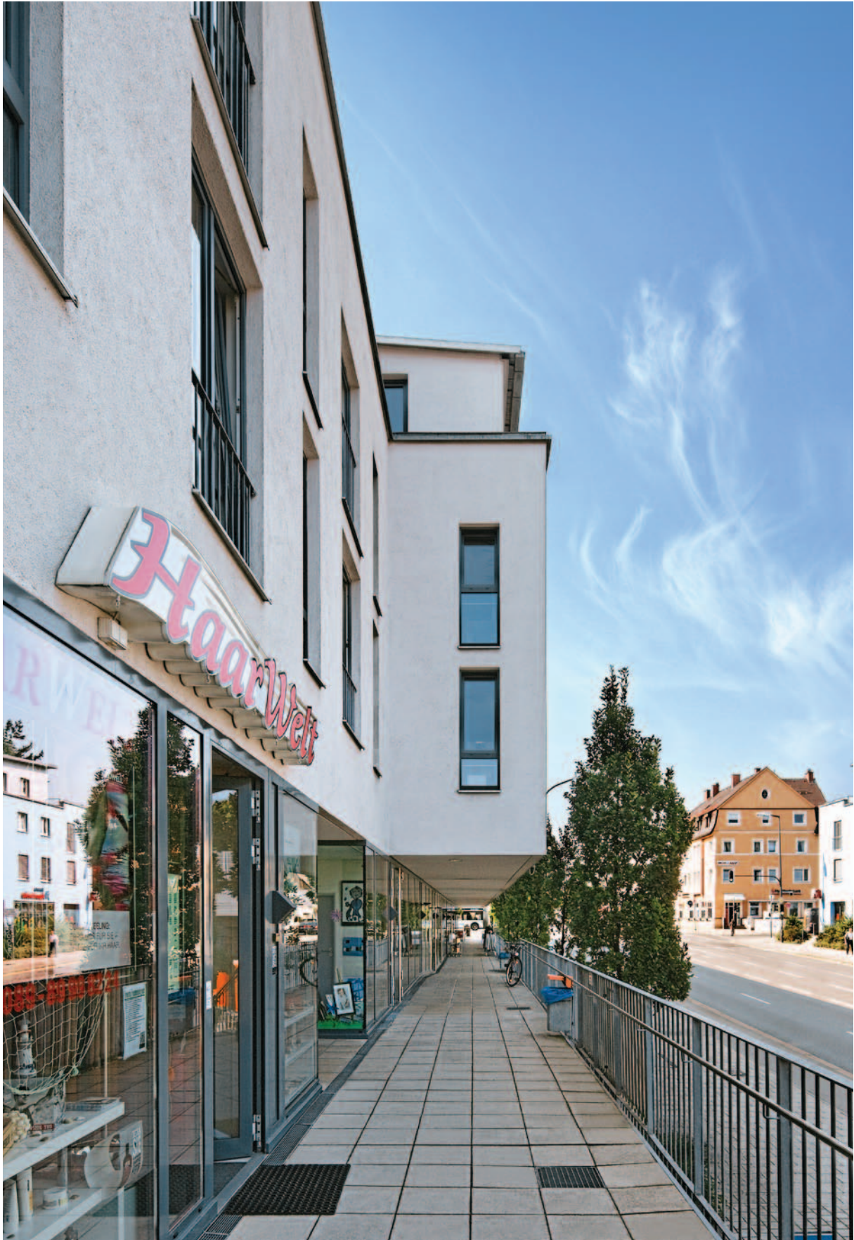
Verdistrasse, Obermenzing, Foto: Bernd Perlbach
