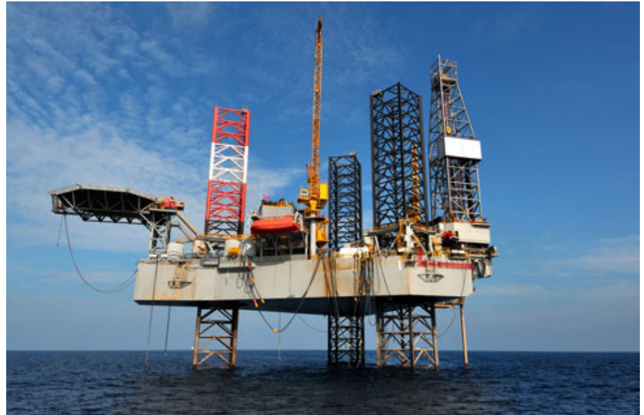
Energisektorn ligger fortfarande kvar på lägre nivåer.
