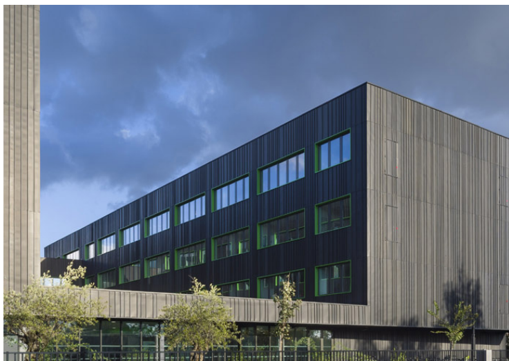
82 CHEMIN DES COURSES - TOULOUSE (31) Vente de 8 900 m 2 de bureaux de MACIF à PAREF Sale of 8,900 sqm of offices from MACIF to PAREF
