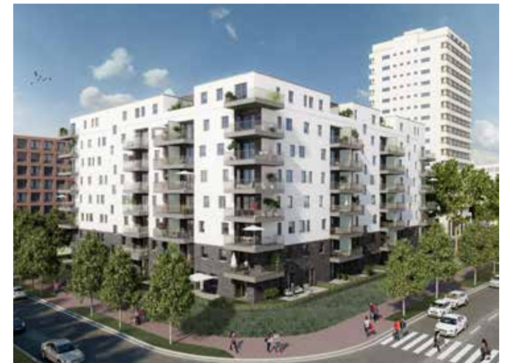
Außenansicht des Living Lyon
