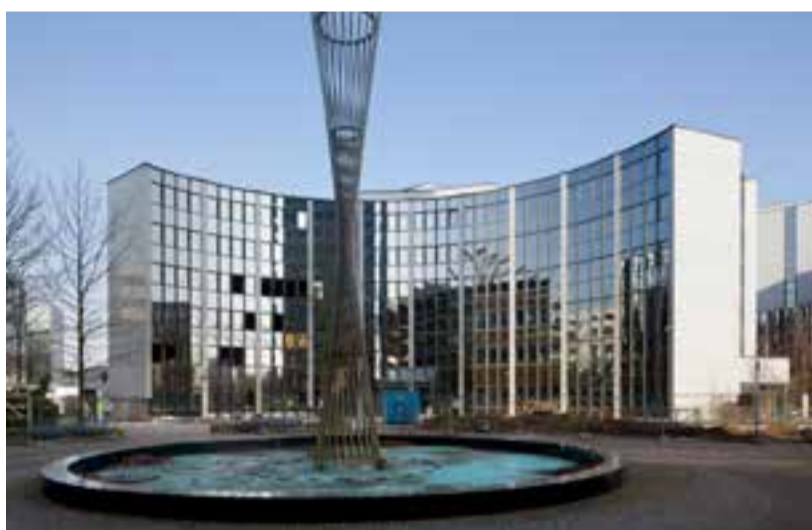
...das alte Thyssen-Trade-Center
