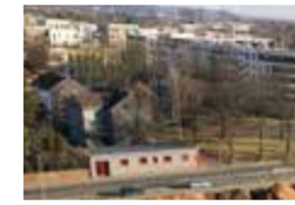
Die Arbeiten haben bereits begonnen...
